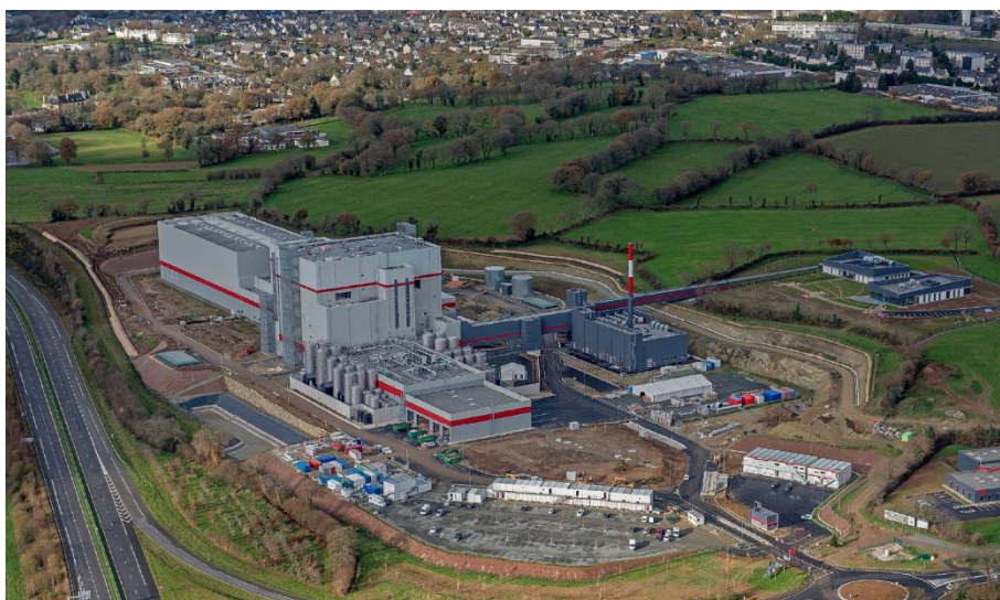
Unité de production de lait infantile en poudre, à Carhaix (29)
