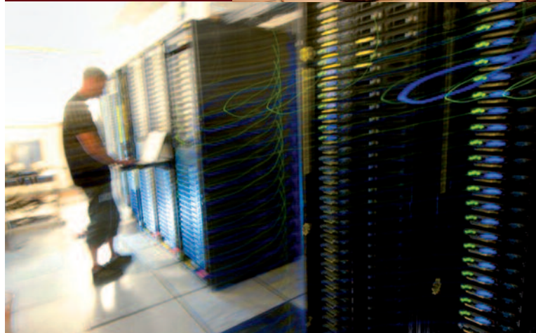
Plate-forme Grid5000 sur le site de l'IRISA
